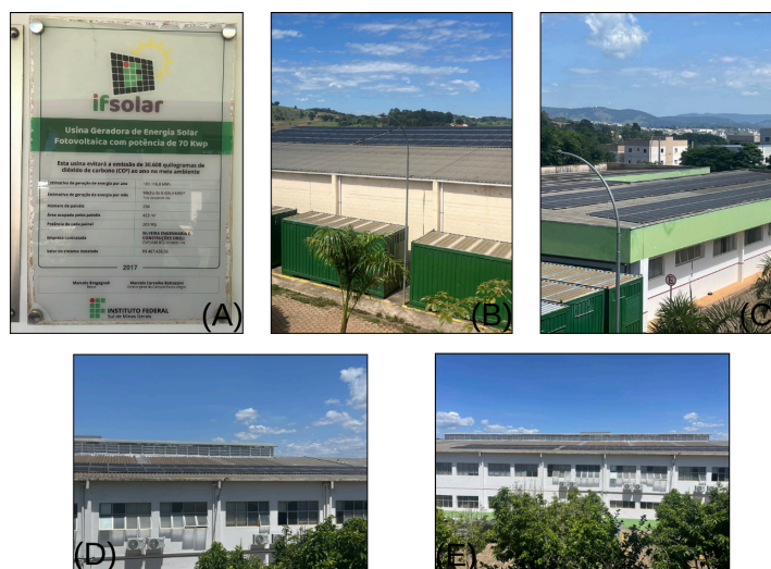
Figura 7 - (A) Placa de descrição do projeto IF solar. (B-E) Distribuição das placas para captação de energia solar.
