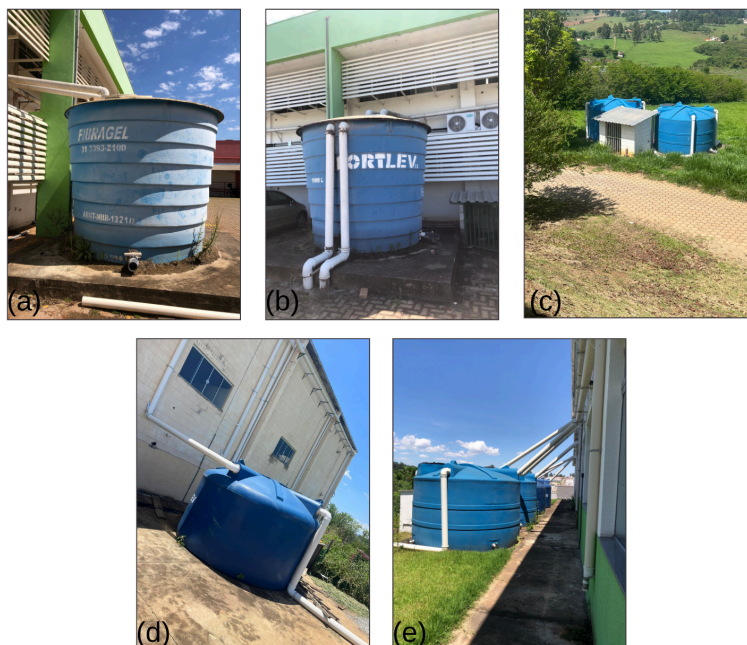
Figura 16 - Caixas d'água para captação de água da chuva.
